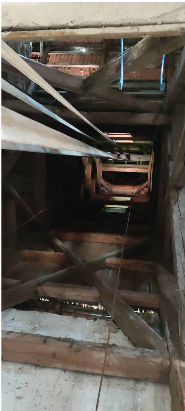
Obr. 5 – pohled na konstrukci věže pro sušení hadic
